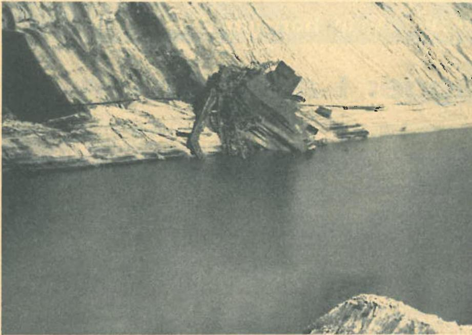
Abbildung 2: 1945 stürzte der Hochbagger I nach hinten ab und fiel in die Tiefbaggerböschung. Durch das Abbrennen der Kohle wurde die darüberliegende Abraumböschung unterhöhlt, und die Abraummassen rutschten über die Kohle. Der Wasserspiegel stand etwa bei + 35
