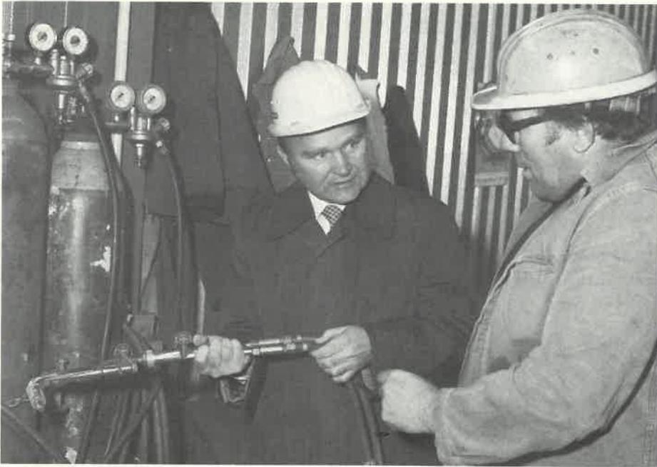
**Bild Seite 26, oben:** Diese Schläuche an einer Stempelentstaubung in der Brikettfabrik Wachtberg sind nicht nur leichter als die bisherigen Rohre, sie lassen sich auch gefahrlos beim Formlegen herausnehmen. Hier begutachten der Leiter des Sicherheitsdienstes Gruppe Süd, Dr. Hartmut Müller-Oehring (links), und Vertreter von Betriebsleitung und Betriebsrat diese Verbesserung
