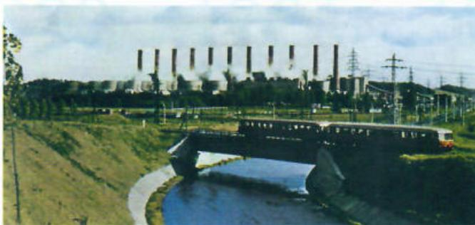
Nach Fertigstellung drei weiterer Blöcke von je 150 MW 1962 ist das Kraftwerk Frimmersdorf Europas größtes Braunkohlenkraftwerk. Mit 1700 MW Gesamtleistung wird das Kraftwerk als wichtiges Glied in der Versorgungskette des westdeutschen Stromverbundes gelobt.
